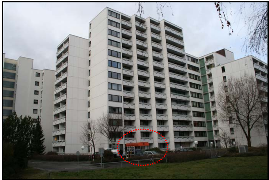
Östliche Ansicht mit Hauszugang:
